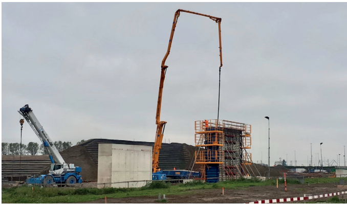
Afbeelding 1 Betonstorten voor steunpunten
