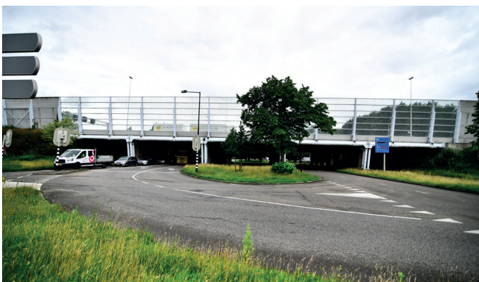
Afbeelding 1 De pijlers van het viaduct over de Holysingel worden gerenoveerd
