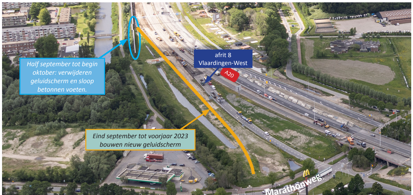
Afbeelding 1 Locaties werkzaamheden geluidscherm langs afrit Marathonweg (foto gemaakt tijdens weekendafsluiting eind mei o.a. voor aansluiting afrit)
