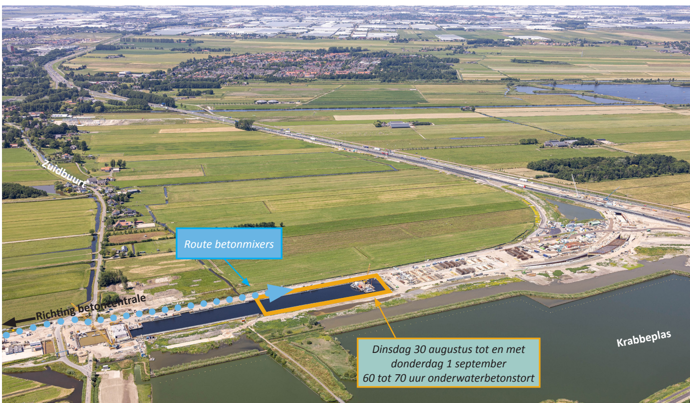
Afbeelding 4 Locatie laatste onderwaterbetonstort toerit Hollandtunnel
