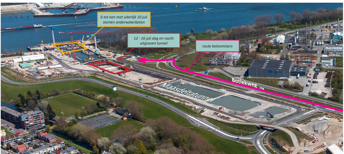
Afbeelding 1 locatie werkzaamheden Hollandtunnel
