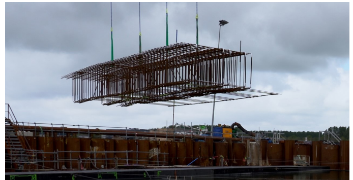
Afbeelding 2 Inhijsen wapeningskorf voor de vloer van de tunnel
