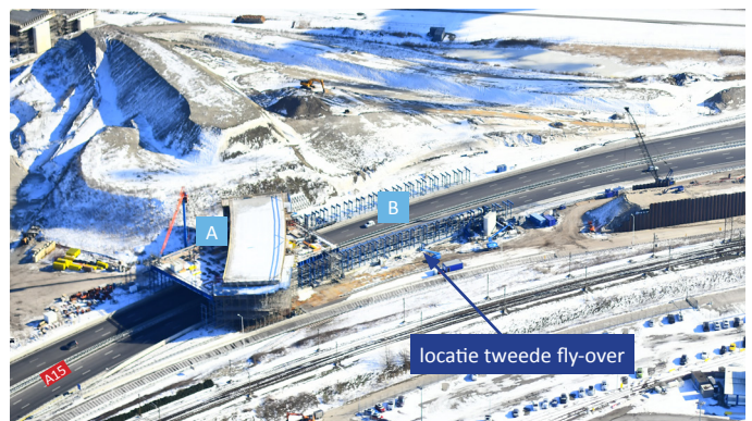
Afbeelding 2 Bouw fly-overs knooppunt Rozenburg
