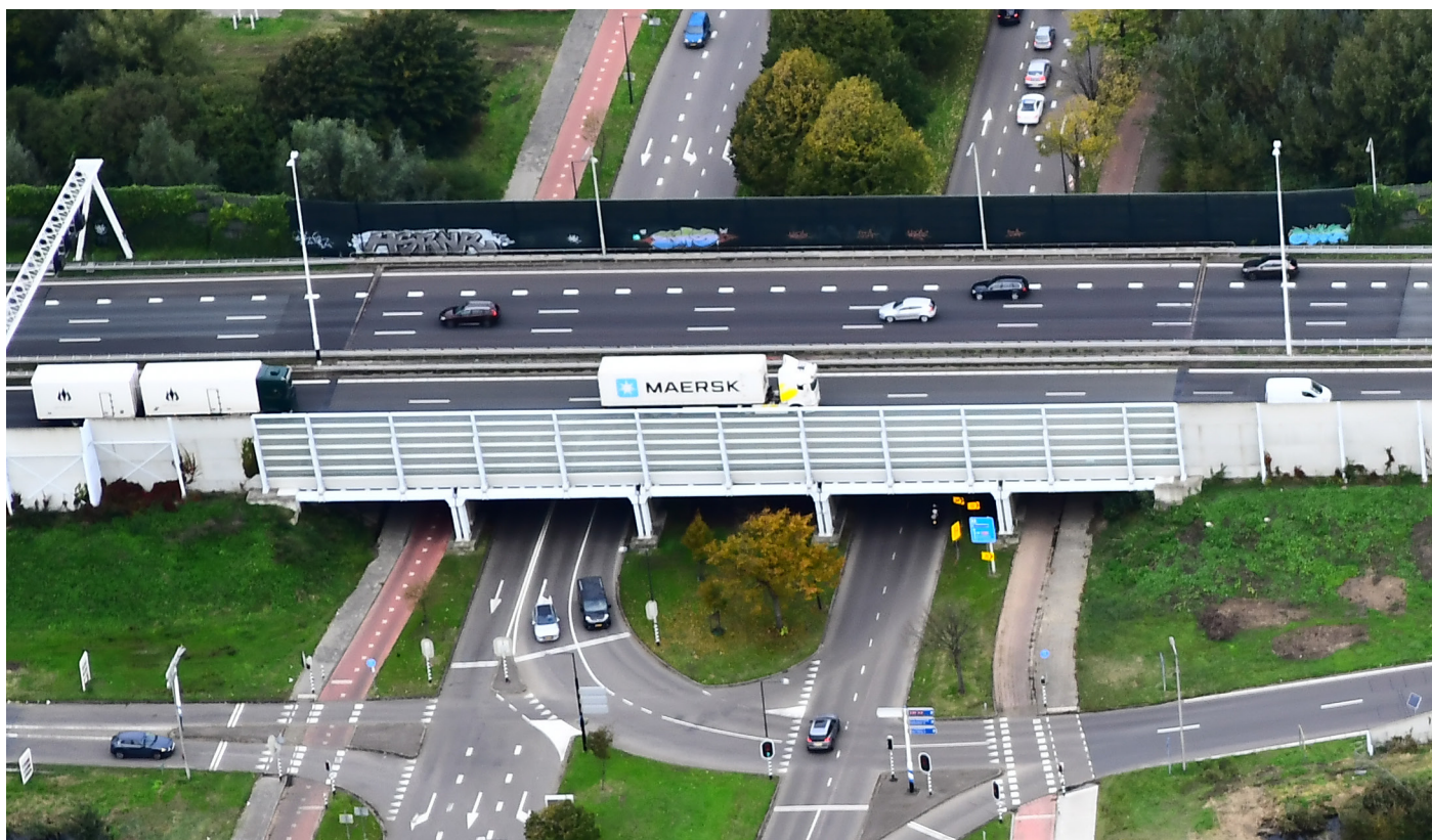
Afbeelding 1 Het viaduct over de Holysingel wordt gerenoveerd
