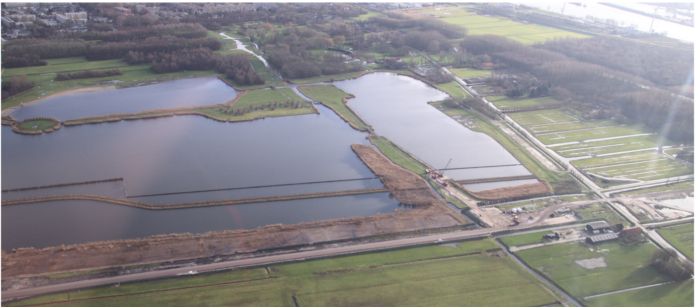
Afbeelding 2 Werkzaamheden bij de Krabbeplass
