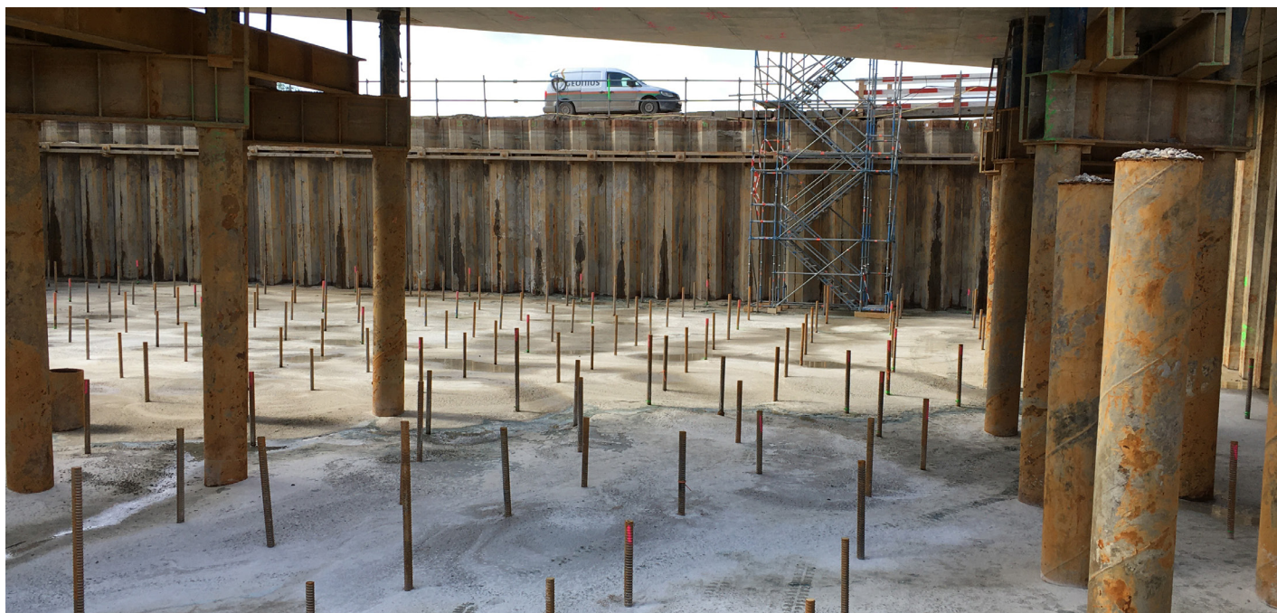
Afbeelding 4 Een drooggepompte bouwkuip (stap 6)
