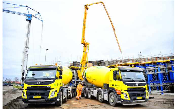
Afbeelding 2 voorbeeld van betonmixers en betonpomp
