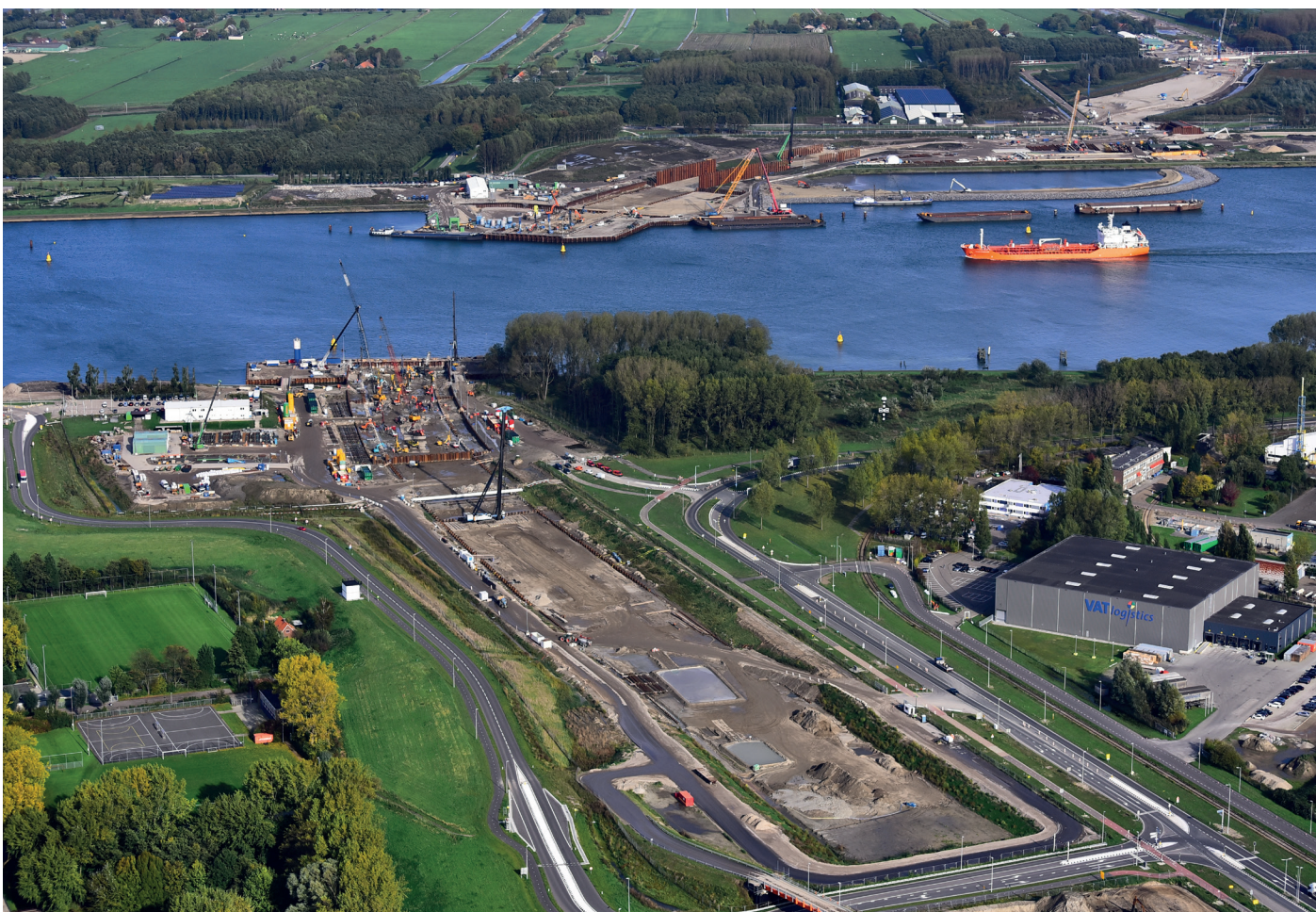
Afbeelding 5 Maasdelatunnel bij Vlaardingen vanuit de lucht (oktober 2019)
