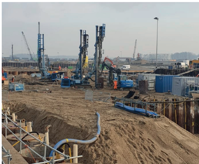
Afbeelding 4 Ankerboorstellingen Maasdelatunnel noord (dec 2019)
