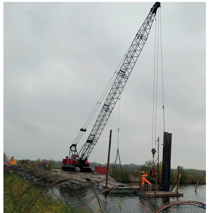
Afbeelding 2 Proef met damwanden in de Krabbeplas
