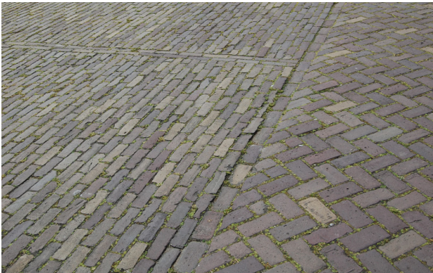
Rijwegen en parkeerterreinen: hergebruik gebakken klinkers
