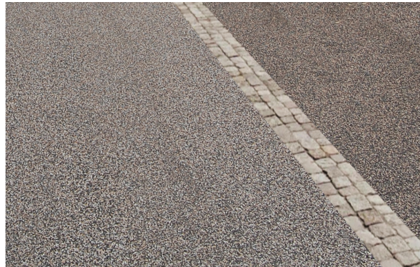
Waterwegboulevard Pad aan het Scheur: zwart asfalt ingewalst met grind met granietkeienmarkering 3 rijen tussen fiets- en voetpad
