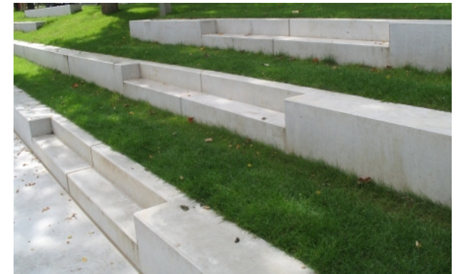
Informele zitplekken aan water en op heuvel betonbanden lichtgrijs 45 cm zithoogte, 40 cm breed, 2 m lang
