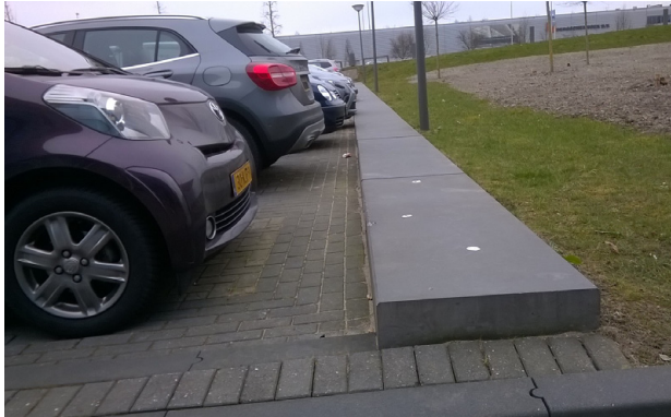
Betonband begrenst parkeerterrein lichtgrijs 20 cm hoogte, 40 cm breed, 1,5 m lang
