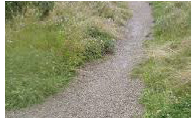
Voetpad van betonpuin
