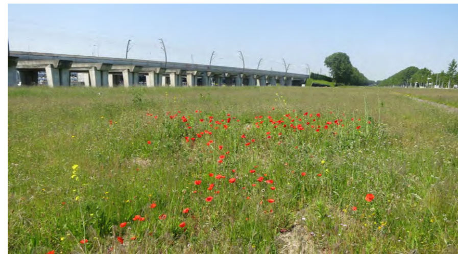
Kabels en leidingenzone
