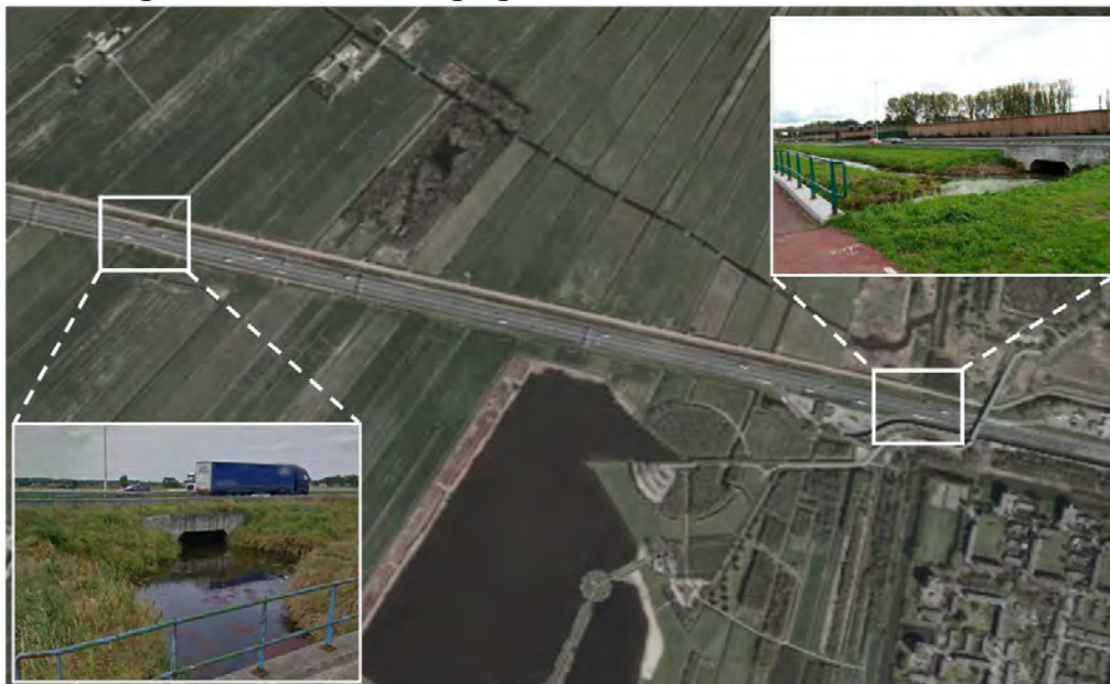
Afbeelding 7.1. Locatie vervanging duikers door ecoduikers
