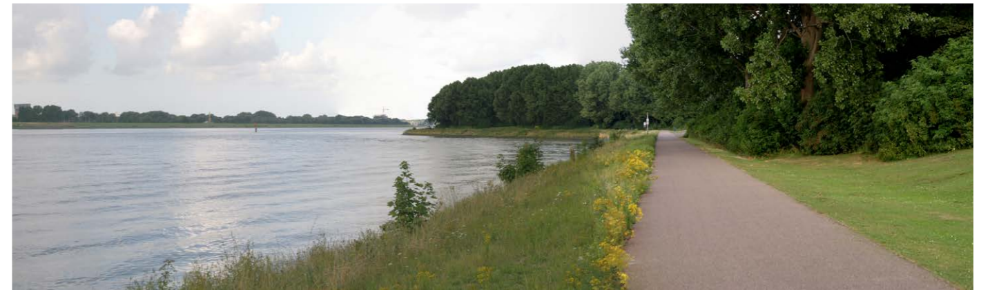
Oeverbos / Het Scheur
